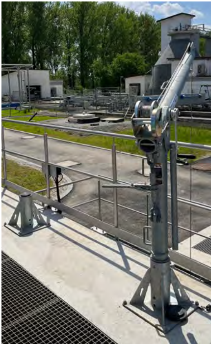
Das Funktionsprinzip überschaubar dargestellt: Ein Standfuß wird an jedem Einsatzort fest montiert, der Davit-Kran im Bedarfsfall hineingesteckt und genutzt.
