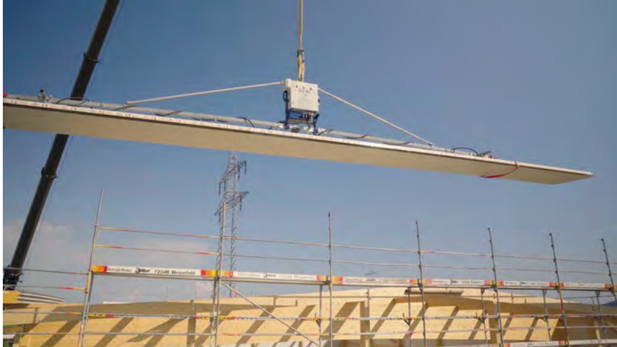
CLAD-BOY® - Das Original! Jahrzehntlang bewährt beim horizontalen und vertikalen Verlegen von Sandwichpaneelen, Trapezblechen, Brandschutz- und Wandelementen.
